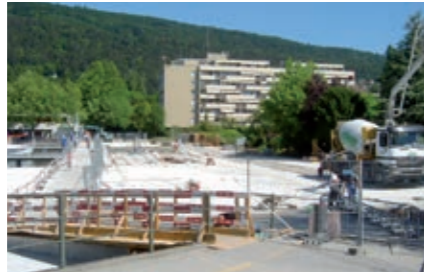
Seeufergestaltung Ländte, Biel
