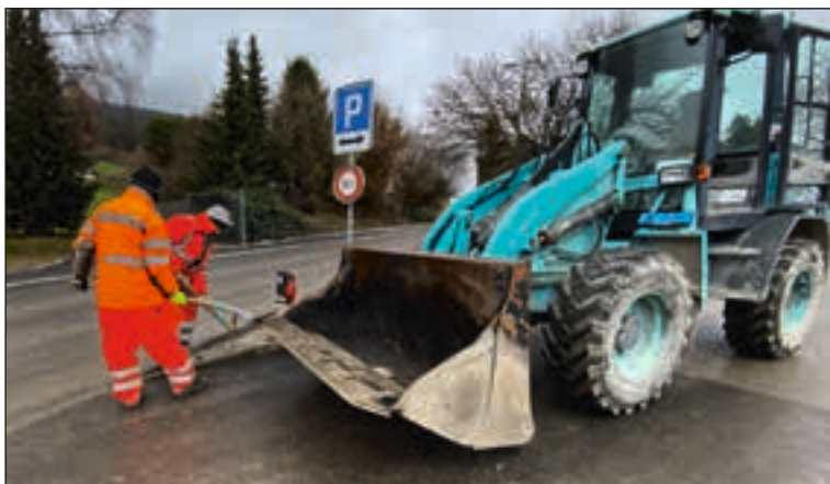
Après le labeur, place au nettoyage, même pour une pelle mécanique.
