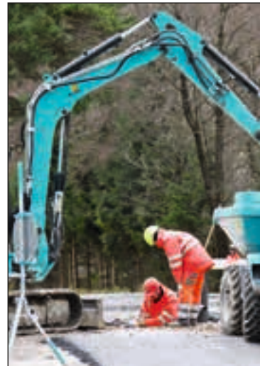
Creusage jusqu'à la conduite à 1m40 de profondeur.
